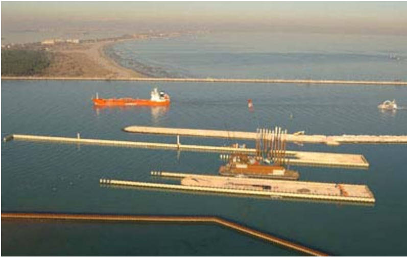
Gennaio 2006: realizzazione della conca di navigazione
