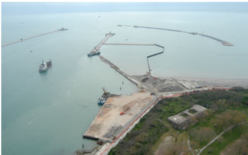
Aprile 2005: realizzazione della conca di navigazione
