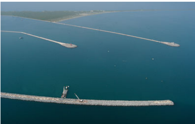
Ottobre 2004: lavori in corso per la costruzione della scogliera
