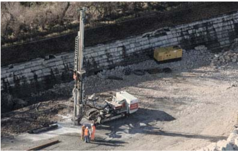
Aprile 2006: Malamocco, Santa Maria del Mare. Infissione dei micropali a protezione dell'area del Forte San Pietro
