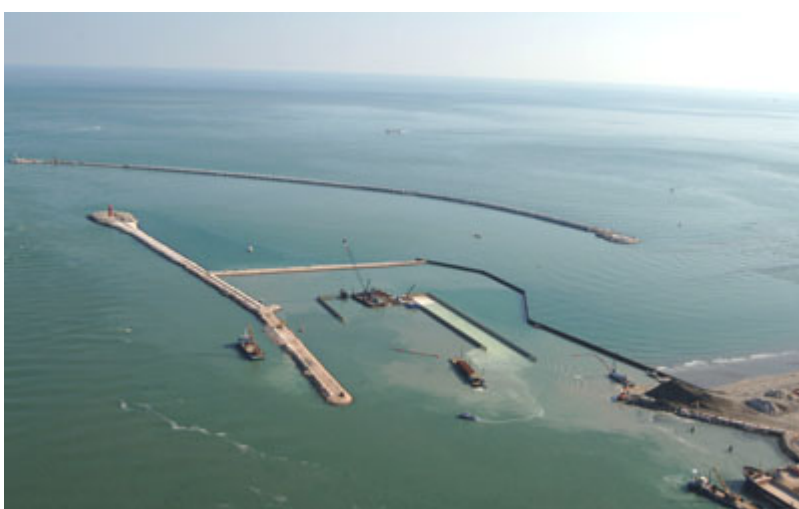
Ottobre 2005: realizzazione della conca di navigazione
