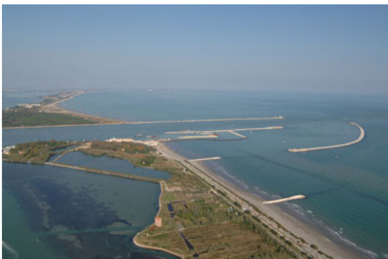
Novembre 2005: un'immagine della bocca di porto: sulla destra, la scogliera quasi ultimata
