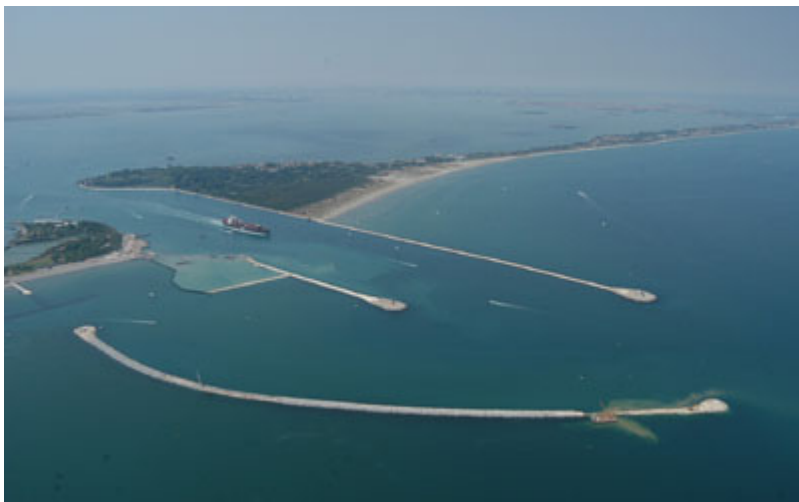
Luglio 2005: la scogliera quasi ultimata e il cantiere per la realizzazione della conca di navigazione
